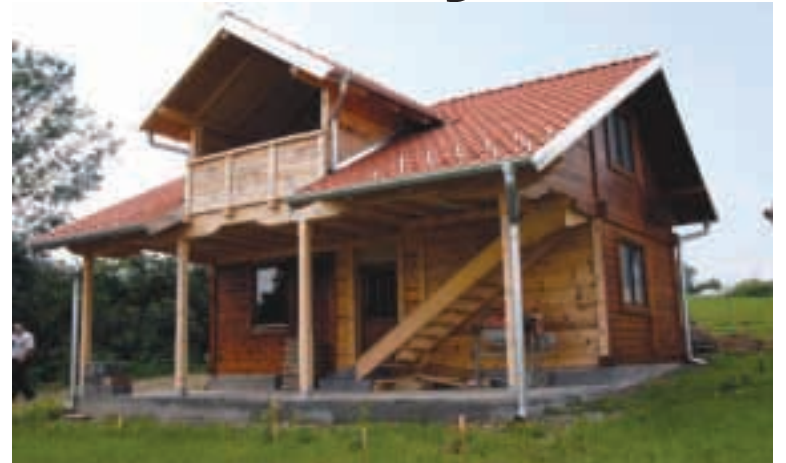
ТЕК ПОДИГНУТА КУЋА УГЛЕДНОГ ЧАЧАНИНА
