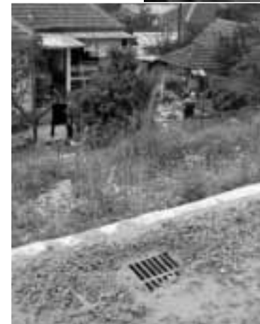
ВОДА СЕ ИЗЛИЛА СА ПУТА ЗБОГ ЗАПУШЕНЕ ШАХТЕ
