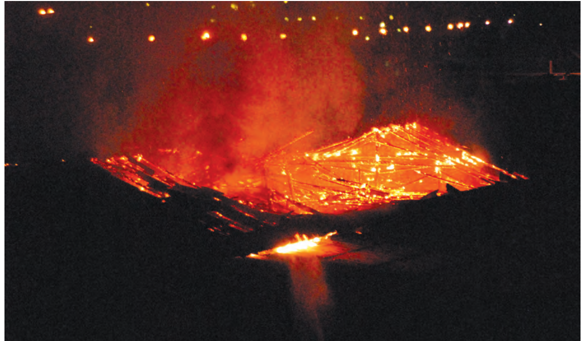
КРОВНА КОНСТРУКЦИЈА ОБЈЕКТА ПОТПУНО ЈЕ ИЗГОРЕЛА
