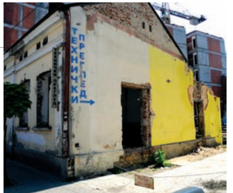
НЕПОРУШЕНИД ЕОЗ ГРАДЕА УТО-МОТОД РУШТВА
