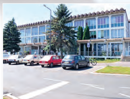
ЗАВОД ЗА ЗДРАВСТВЕНУ ЗАШТИТУ РАДНИКА
