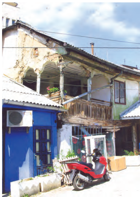
НЕКАДАШЊИ ИЗГЛЕД ЗГРАДЕ, ПОГЛЕД ИЗ ДВОРИШТА
