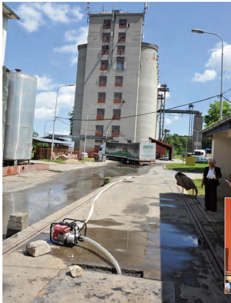
ИСПУМПАВАЊЕ ВОДЕ ИЗ СИЛОСА
