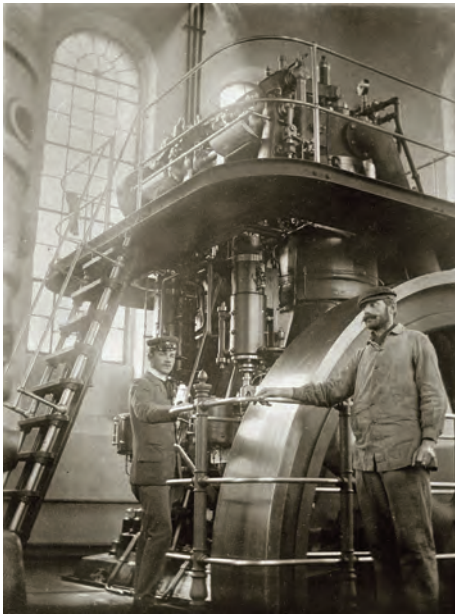
ЕЛЕКТРИЧНА ЦЕНТРАЛА ВОЈНОТЕХНИЧКОГ ЗАВОДА ОКО 1910-14. ГОДИНЕ
