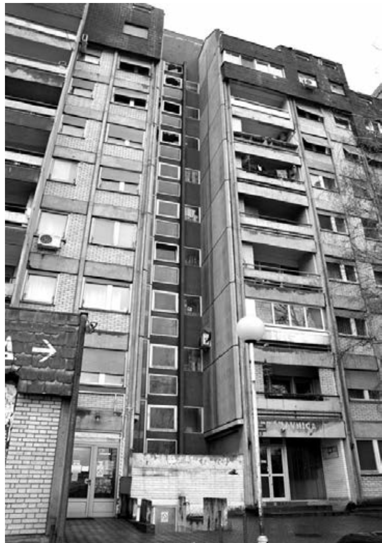
ЗГРАДА У СВЕТОГОРСКОЈ 3 ОСТАЛА БЕЗ ЕЛЕКТРОВИДОВА
