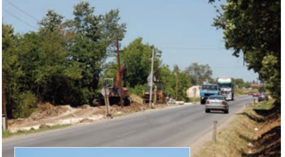
ИЗГРАДЊА КИШНЕ КАНАЛИЗАЦИЈЕ ЗА НОВЕ ДВЕ ТРАКЕ УЛИЦЕ
