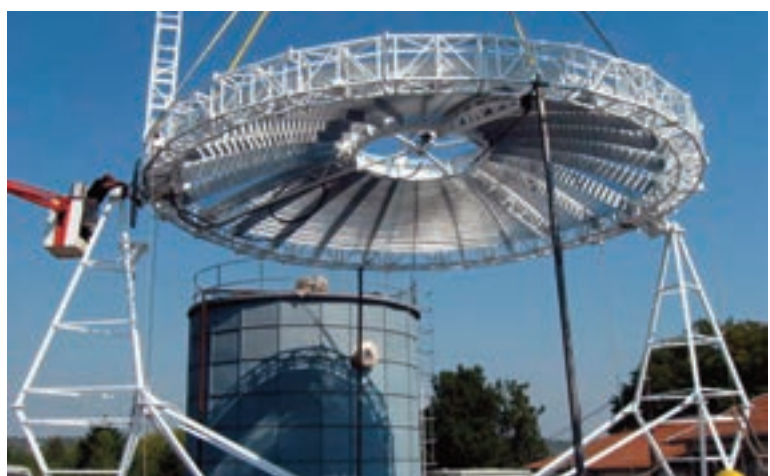
ПОСТАВЉАЊЕ КОНЦЕНТРАТОРА У БАДЊЕВАЦУ, У ПОЗАДИНИ СОЛАРНА ТОПЛАНА ВИСОКА 18 И ПРЕЧНИКА 13 МЕТАРА
