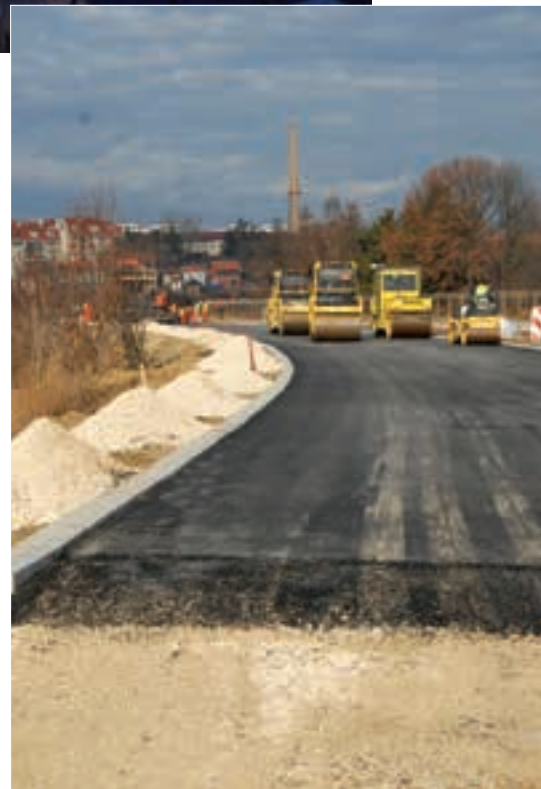
ИЗГРАЂЕНА НОВА ТРАСА УЛИЦЕ КА ЕРДЕЧУ
