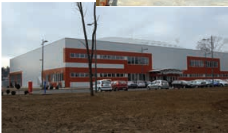
ИЗГЛЕД ЗАВРШЕНОГ БАЗЕНА
