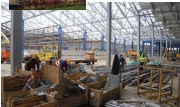
СТАРЕ ХАЛЕ У ВРЕМЕ РЕКОНСТРУКЦИЈЕ, КАДА ЈЕ БИЛО ДОЗВОЉЕНО СНИМАЊЕ
