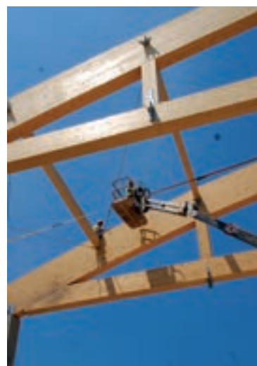
МОНТАЖА КРОВНЕ КОНСТРУКЦИЈЕ
