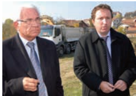
ГРАДОНАЧЕЛНИК СТЕВАНОВИЋ И ЊЕГОВ ЗАМЕНИК ЗДРАВКОВИЋ НА ГРАДИЛИШТУ НОВЕ УЛИЦЕ
